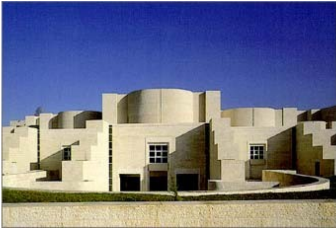
L'entrée au-dessous du niveau du sol
